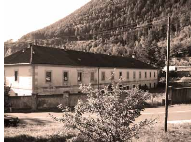
Umbau Liegenschaft C: Das zu sanierende „Geniegebäude“ als operativer Sitz für die Gesellschaft des BBT
